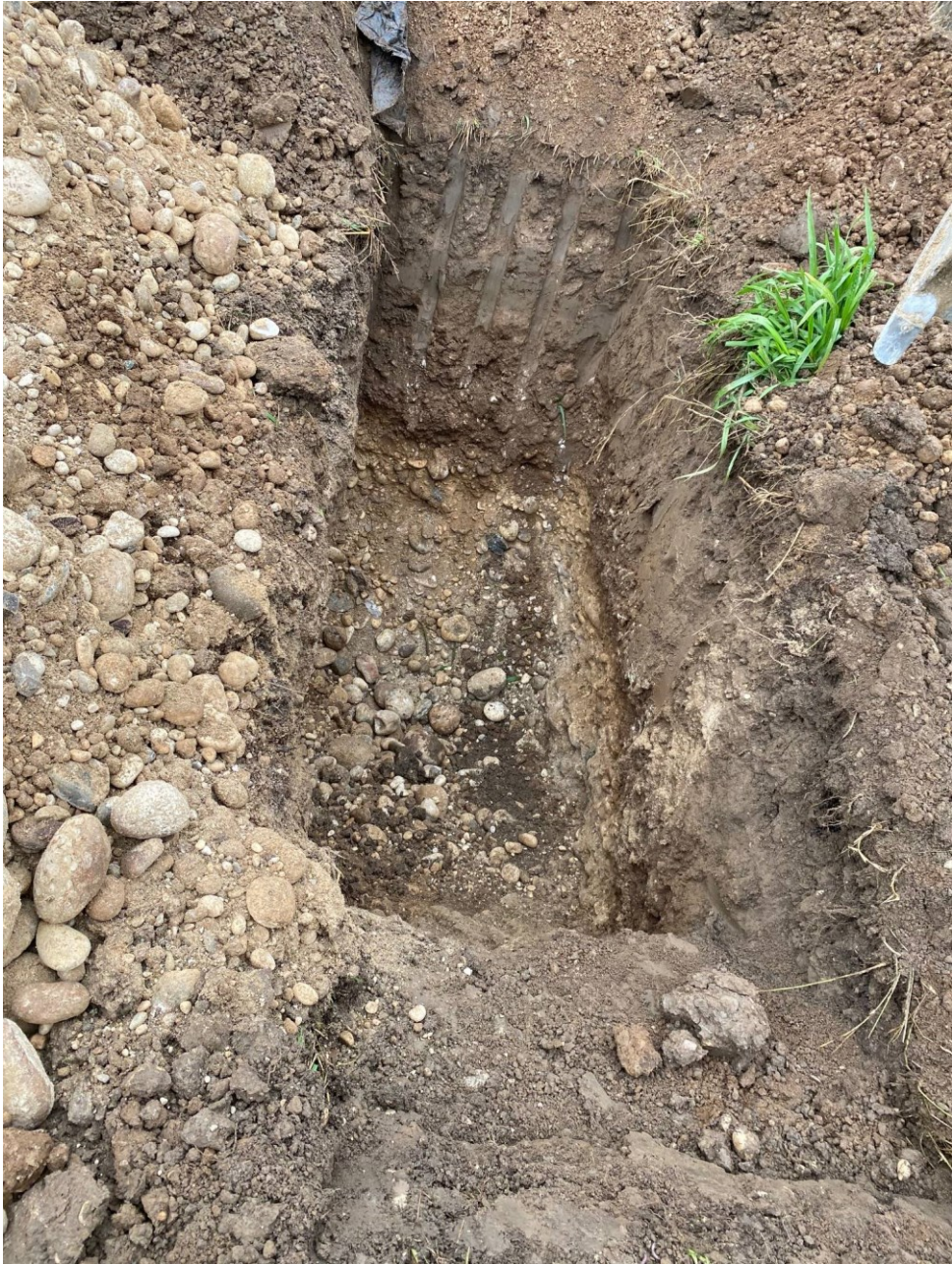
Foto 2: vista di una ulteriore trincea di scavo (S2)
